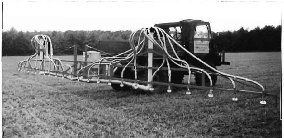
*Platz-Granulatgerät Typ 1968 mit zwei Verteilerköpfen in der Mitte eines jeden Auslegers ganz rechts und links, angebaut an einen Unimog bei der Vorführung auf Gut Düendorf*
